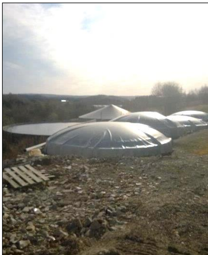
Foto 8: Biogassanlegg ved Holum gård; Knut Samseth
