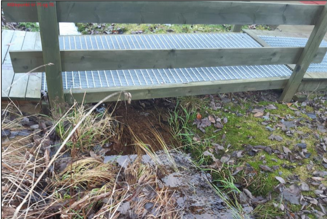
Figur 38: Gangbru ved Bevregrasveien 2
