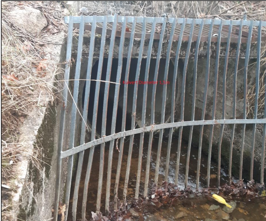
Figur 30: Innløp til kulvert under Nittedalsveien
