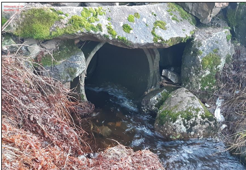
Figur 19: Innløp til kulvert nedstrøms Bjønndalsmyra (punkt 2 i Tabell 7)
