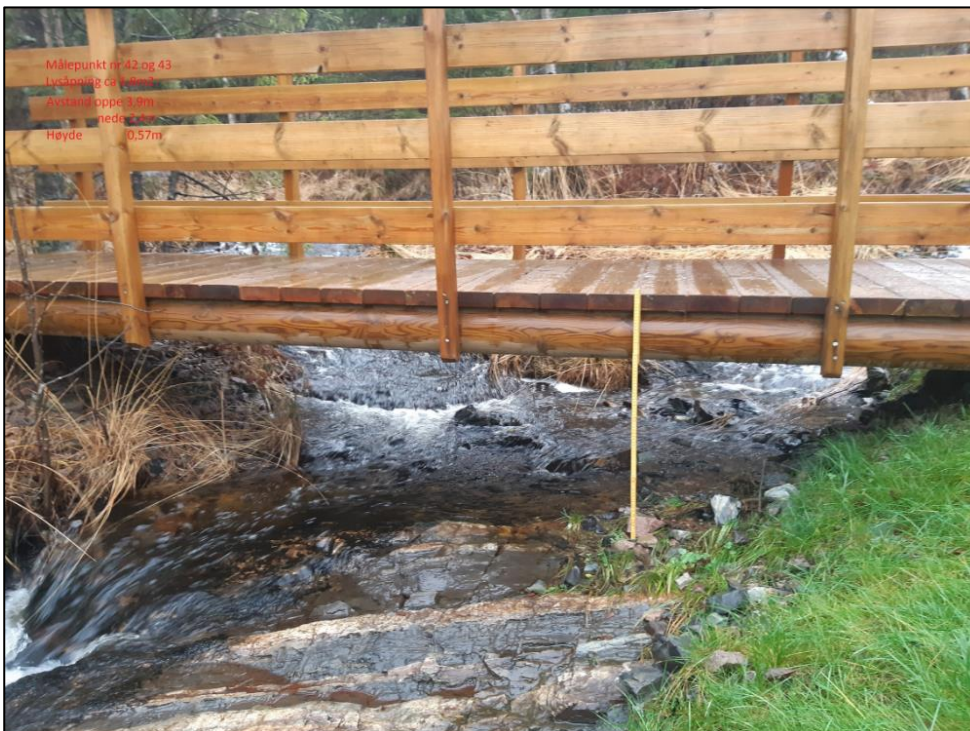
Figur 35: Gangbru ved Skyttamyerveien 118
