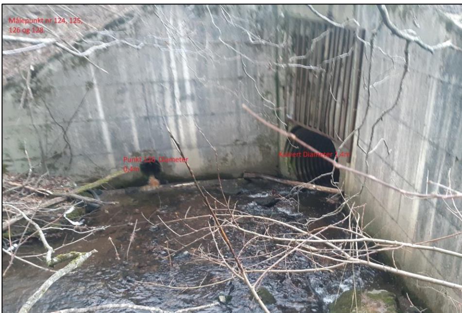
Figur 31: Innløp til kulvert under Skyssetveien
