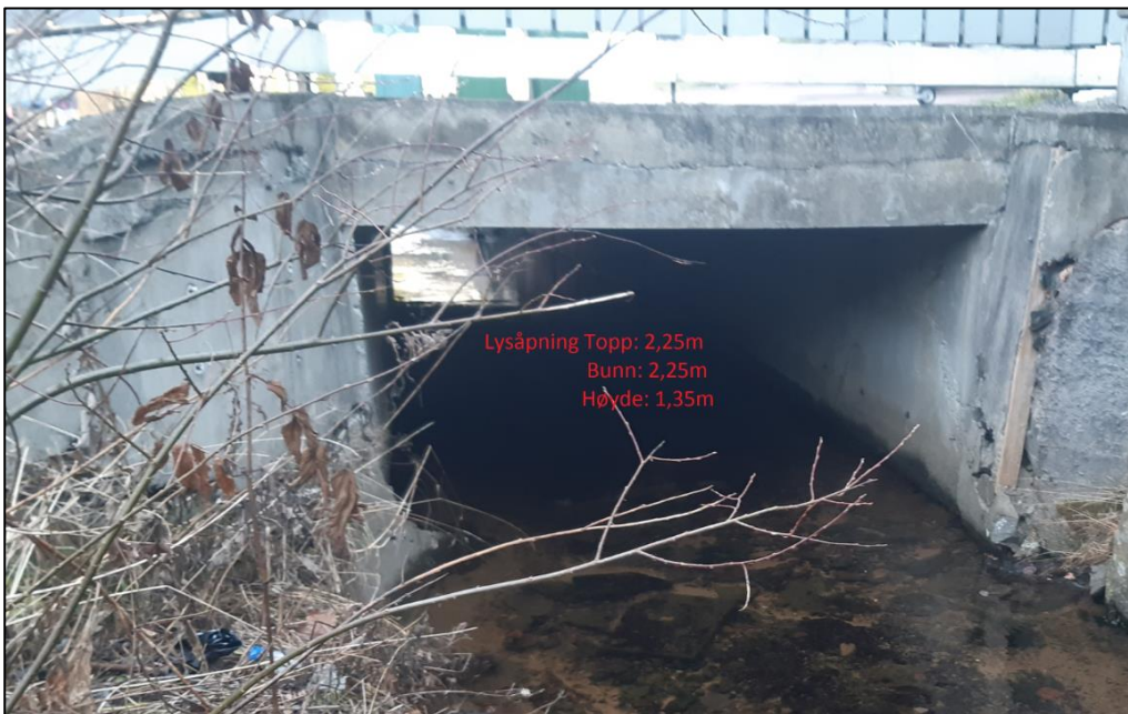
Figur 29: Kulvert under innkjøring til Bekkefare 7 og 9
