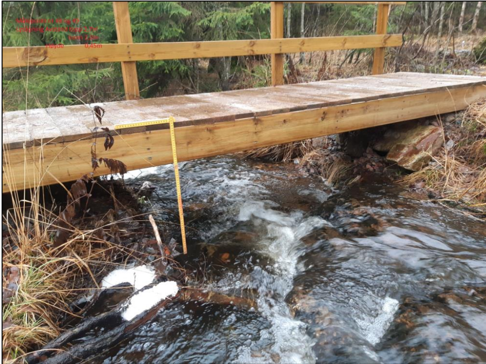
Figur 36: Gangbru nedstrøms Skyttamyveien 118
