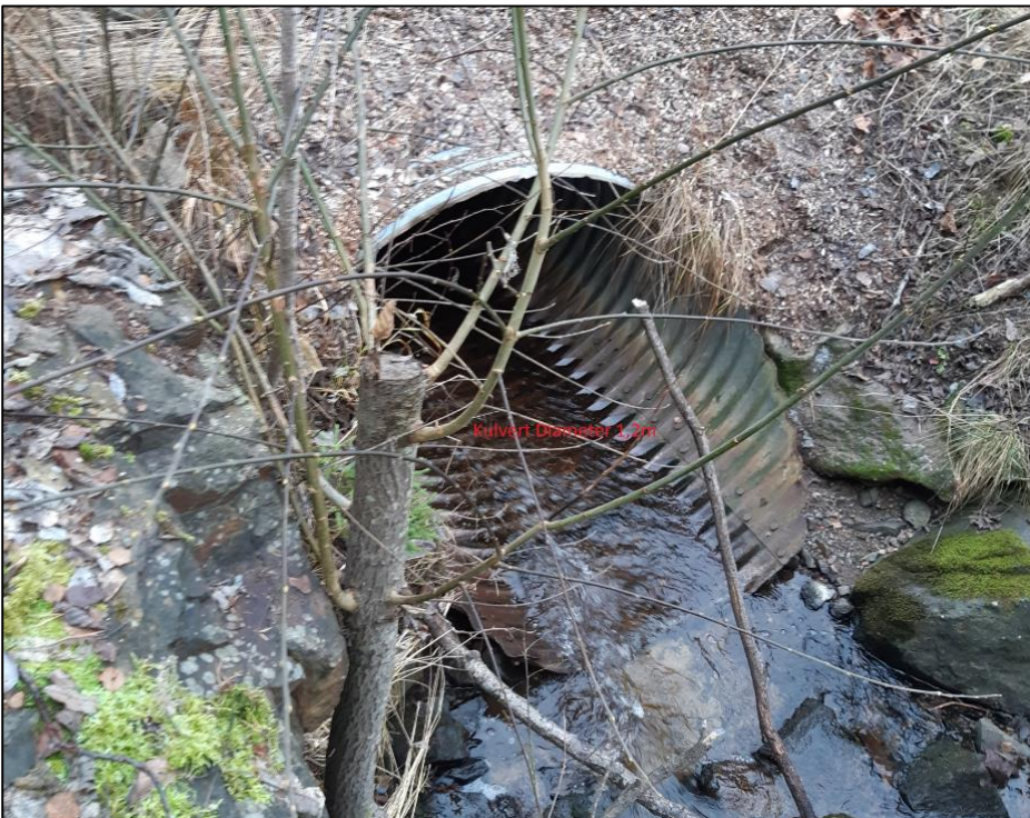
Figur 27: Innløp til kulvert under Briskeveien
