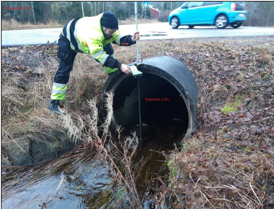
Figur 22: Innløp til kulvert under Porsveien
