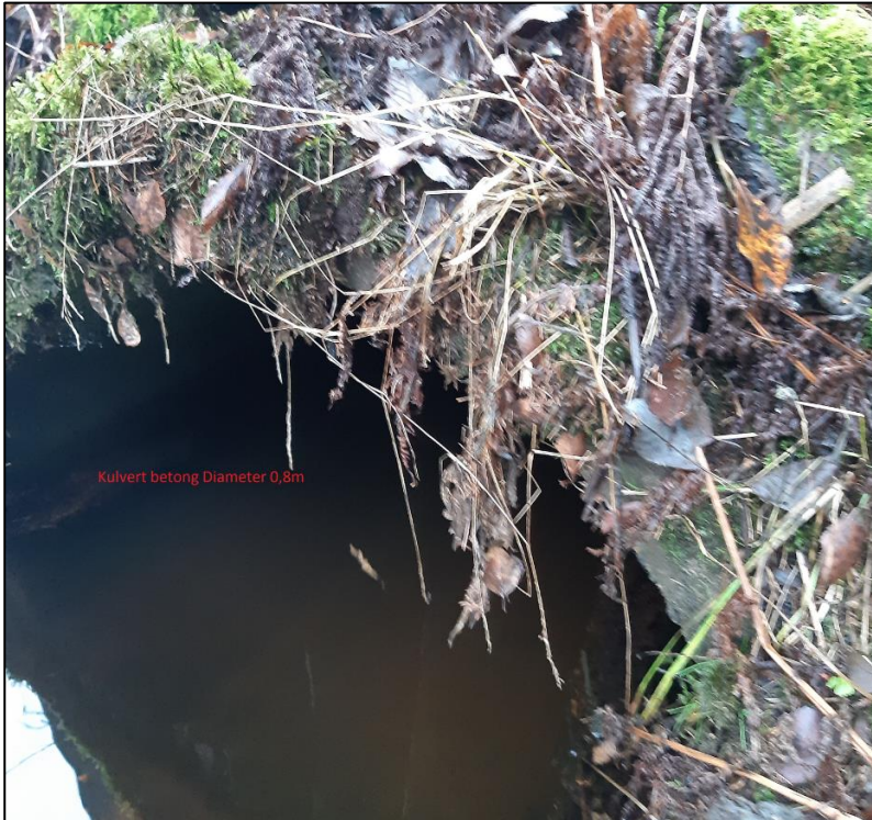
Figur 20: Innløp til stikkrenne gjennom gangvei ved Skyttamyra
