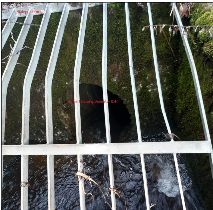
Figur 23: Innløp til stikkrenne nedstrøms Skyttaputten
