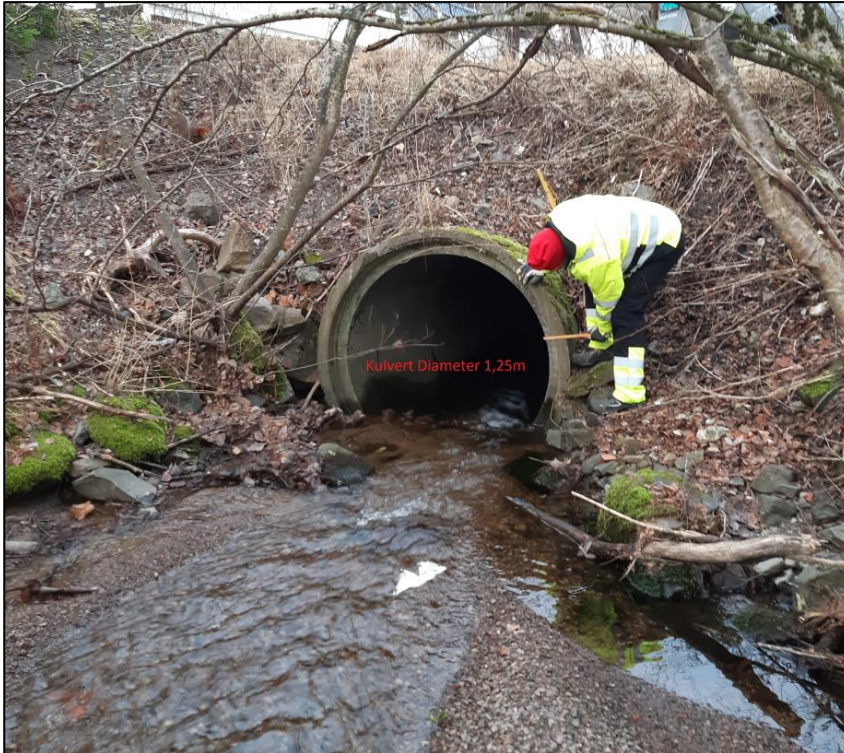
Figur 28: Innløp til kulvert under Glenneveien
