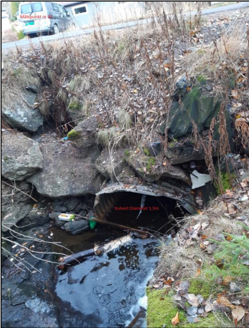
Figur 26: Innløp til kulvert under vei Bekkelia
