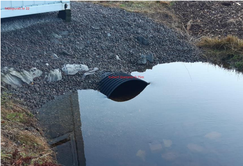
Figur 18: Innløp til kulvert nedstrøms Bjønndalsmyra (punkt 1 i Tabell 7)
