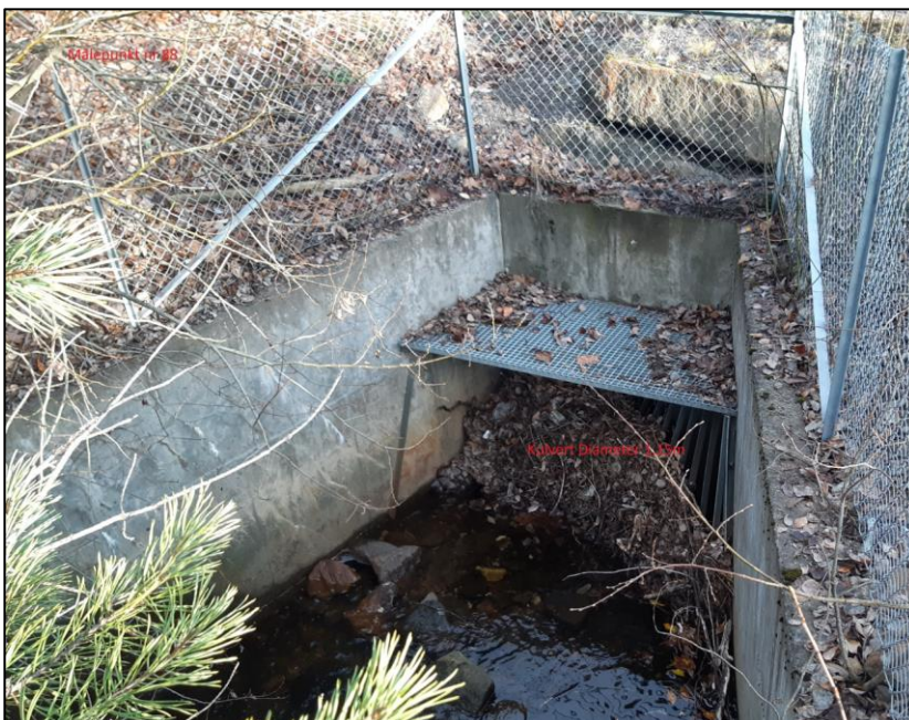
Figur 25: Innløp til stikkrenne under Brenneveien
