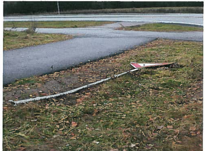
Bilde: Nedkjørt vikepliktsskilt, Vargveien.
