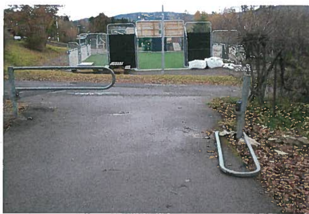
Bilde: Ødelagt bom, Nordfaret.
