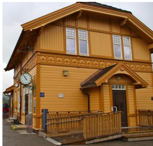
Stasjonsbygningen på Nittedal stasjon. Foto: Margret Lie Wessel
