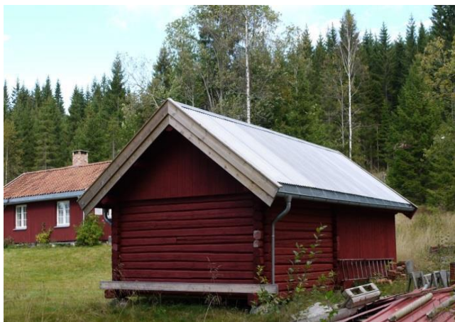
Godt bevart uthus på Fossestua øst for Ørfiske. Huset var tidligere truet av forfall, men de senere årene er bygningen istandsatt. Materialer er skiftet ut og huset er flyttet, men byggestil og volum er bevart. Foto: NIKU
