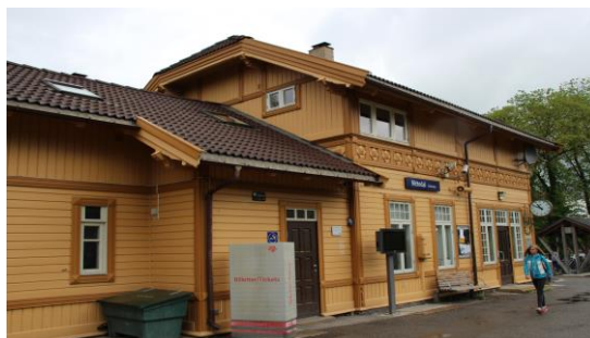
Nittedal stasjon, bygget på Strømmen Trevarefabrikk. Foto: Margret Lie Wessel
