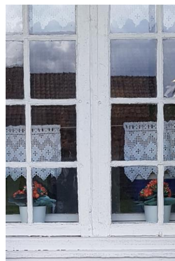
Godt bevart vindu på hovedbygningen på Nedre Skyset. Foto: Nittedal kommune
