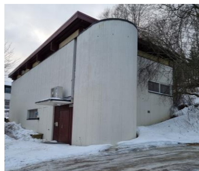
Telestasjonen i Kirkeveien 13. Foto: Nittedal kommune
