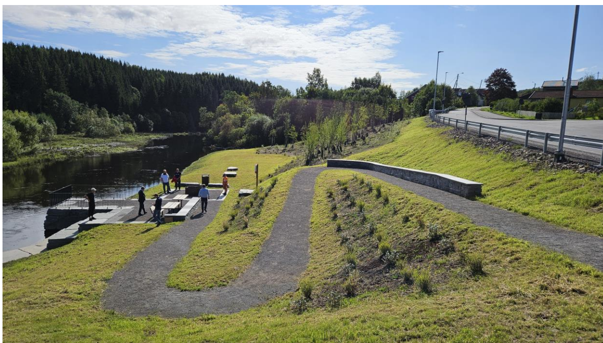
Friområdet på Li der leirskredet gikk i 2019 sto ferdig opparbeidet høsten 2023. Anlegget gir innbyggerne en universelt utformet adkomst til Nitelva. Her kan man sette ut kano, grille, fiske og nyte nærheten til naturen.
