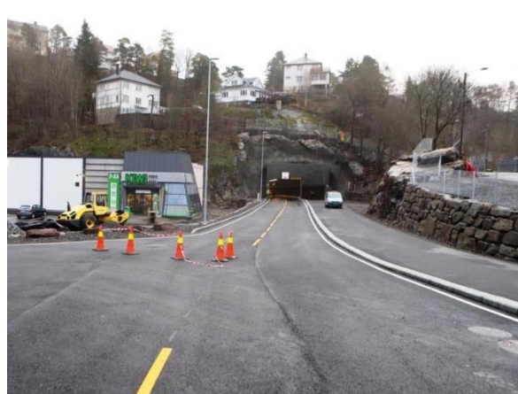
Bilde 11 Ny adkomsttunnel fra Myrene i vest
