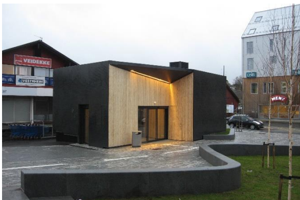
Bilde 21 Inngang fra byrom til heishus
