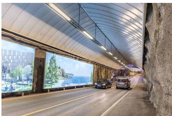
Bilde 25 Adkomsttunnelen til anlegget
