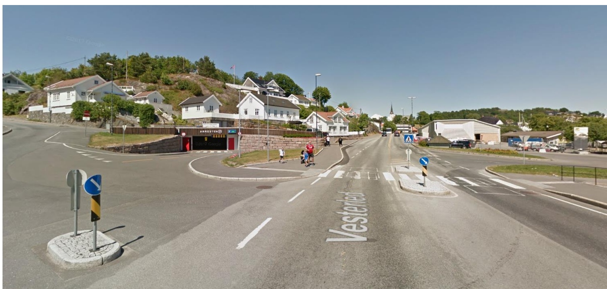
Bilde 16 Avkjørsel til parkeringsanlegget fra Vesterled (fv 420)
