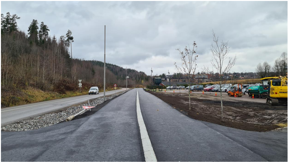
Gang- og sykkelvei langs Svartkruttveien mellom rådhuset og Nittedal hestesenter ble anlagt høsten 2022. Foto fra 4. november 2022.
