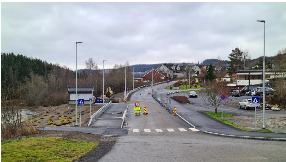
Skredområdet på Li etter gjenoppbygging av kommunal infrastruktur. Foto fra 4. november 2022.
