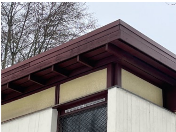
Utsnitt – betongvegg og takkonstruksjon
