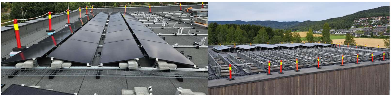
Montering av solceller på tak av Nittedal u-skole og Elvetangen skole.
