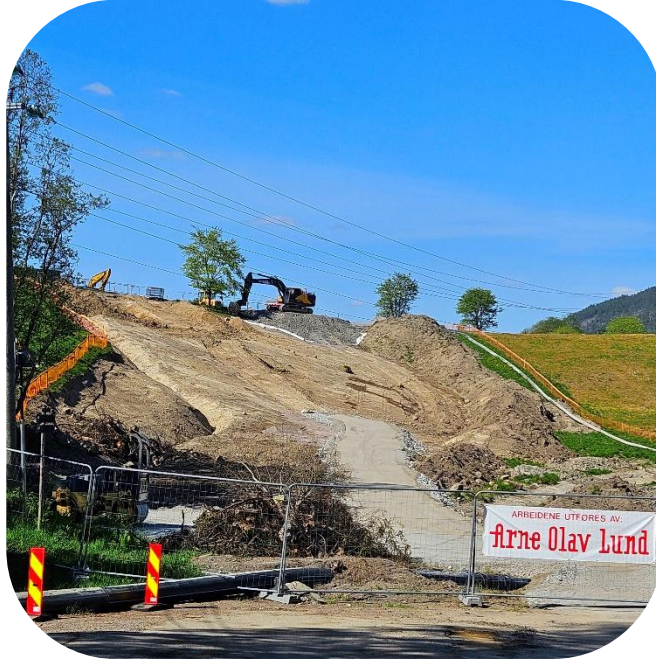
Bilde 24 - Arbeidene med VA på langs er godt i gang. Bildet er tatt ved Slattum sommer 2024.
