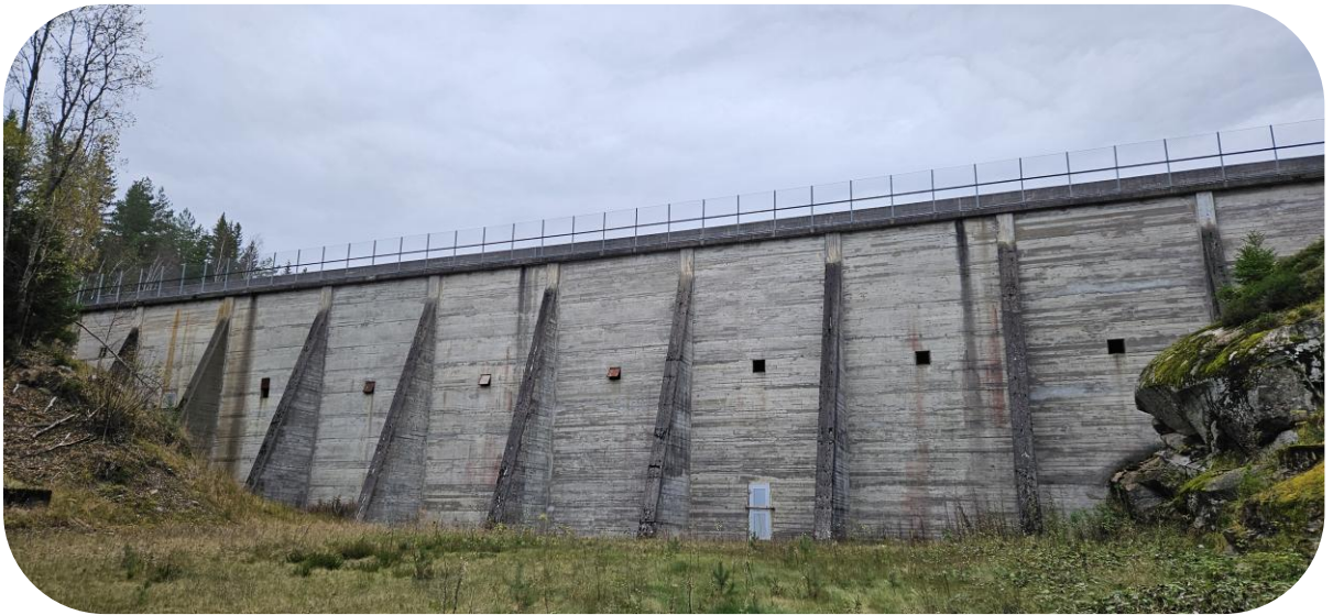
Bilde 12 - Den vestre Høldippeldammen skal forsterkes ved å fylle betong inni konstruksjonen.
