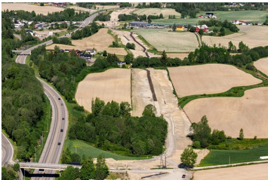
VA på langs har vært godt synlig for innbyggerne, og berørt mye areal. Det meste av infrastrukturen har kommet på plass i 2025.
