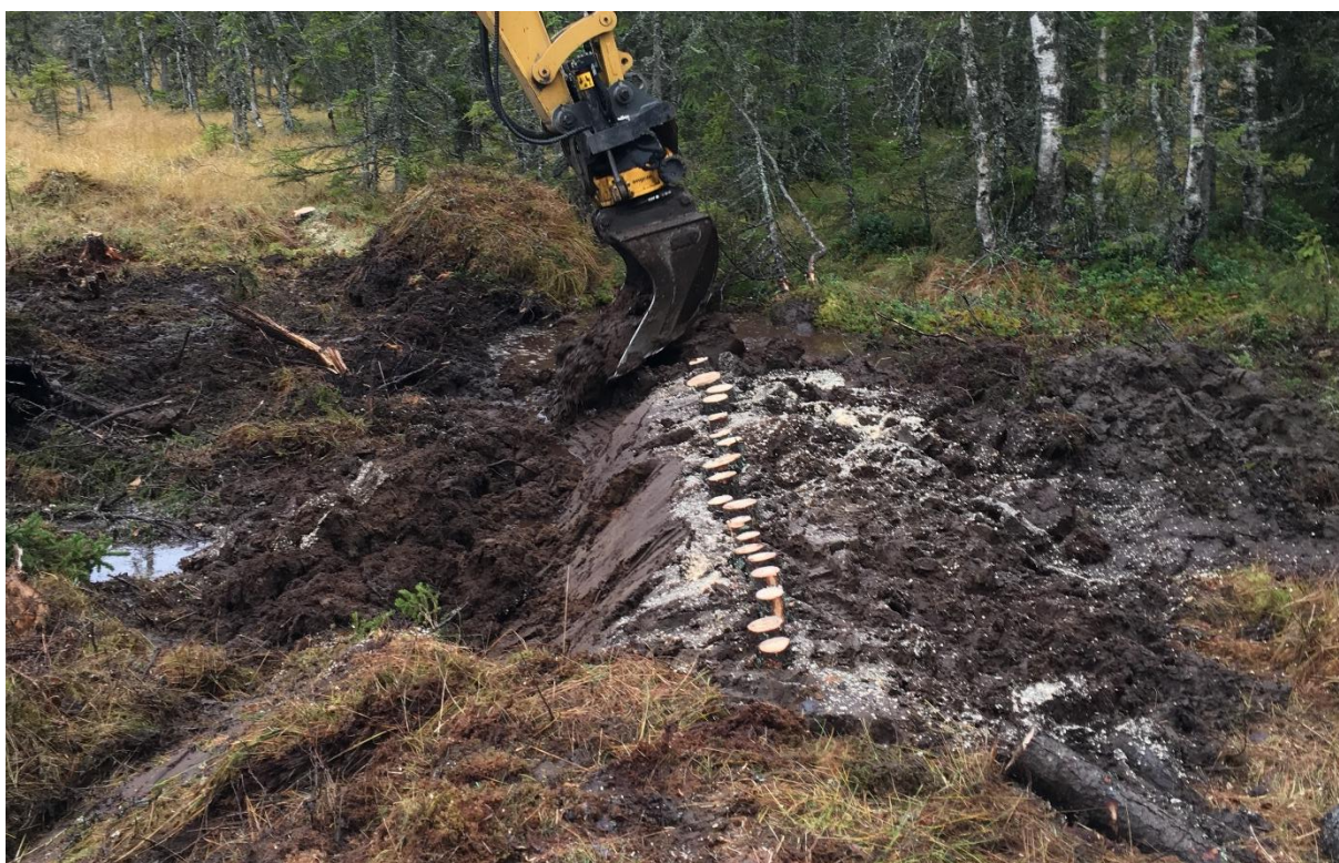
Figur 32: Forsterket demning med stående tømmerstokker. Vindflomyra 17.10.2017. Foto: Kjølvs Ø. Falklev
