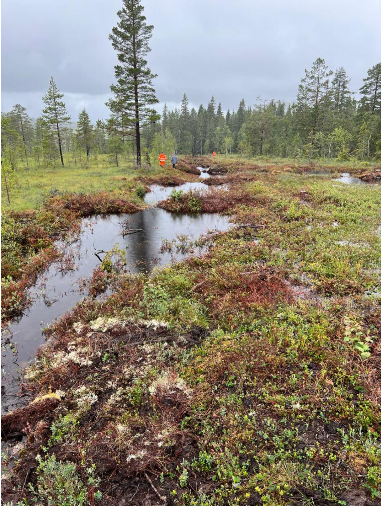
Figur 25: Flere demninger med brudd grunnet bruk av stein i demningen. Hele denne jobben måtte gjøres opp igjen. Hemberget 2023. Foto: Suzanne Wien
