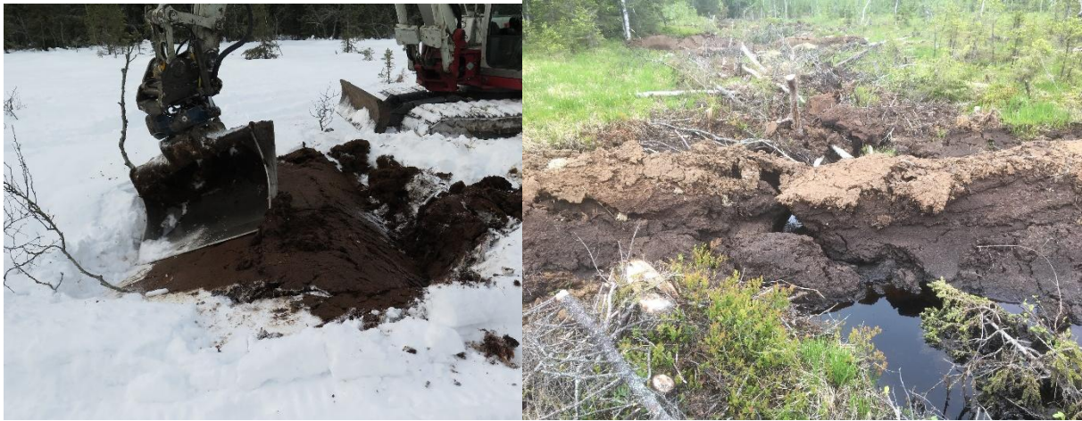
Figur 26: Bygging av demninger vinterstid er ikke å anbefale. Bygging til venstre og resultatet til høyre. Foto: Kjøl. Ø. Falklev
