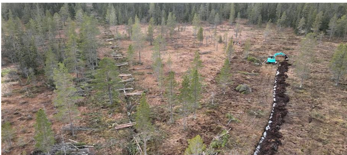
Figur 28: Tømmerstokker som er lagt klare der det seinere skal bygges forsterkede demninger, Vollmyra i Rendalen kommune. Foto: Kjølsv Ø. Falklev
