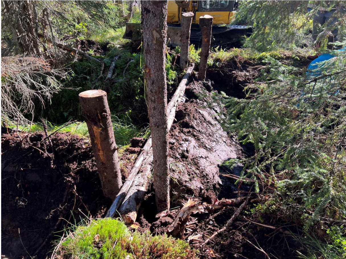
Figur 30: Tilnærmet fullført demning forsterket med tre.
