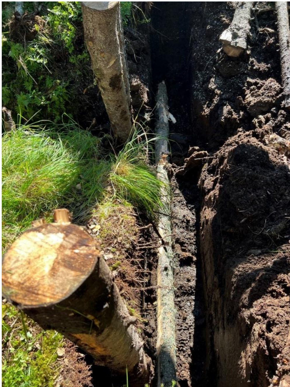
Figur 29: Begynnelsen på en demning forsterket med tre. Her er det også satt to støttestokker midt i grøfta. Grøfta går fra høyre til venstre i bildet.
