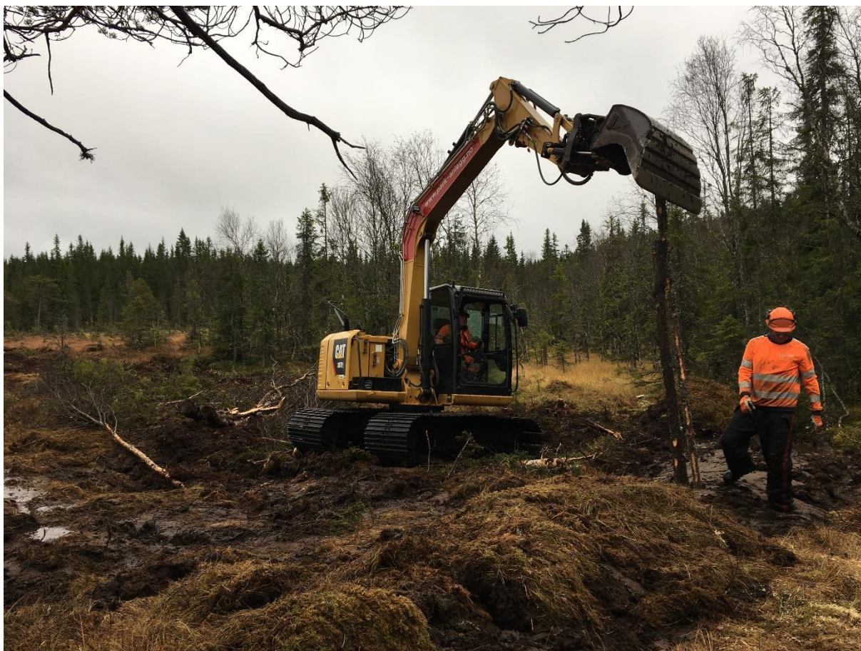
Figur 31: Forsterket demning med stående tømmerstokker. Vindflomyra 17.10.2017. Foto: Kjølvs Ø. Falklev
