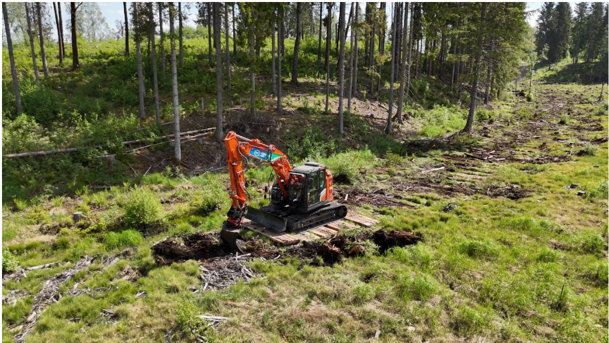
Figur 22. Gravemaskin står på stokkmatter, som ligger midt på grøfta. Han tetter grøfta foran seg, og stokkmattene komprimerer massene han nettopp har lagt ned. Fra Skjerven i Maridalen landskapsvernområde. Foto: Eirik Walle, SFOS.
