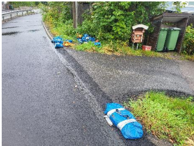
Eiendom i nedre del av Stasjonsveien, der det er problemer med overvannsflom ved store regnhendelser.
