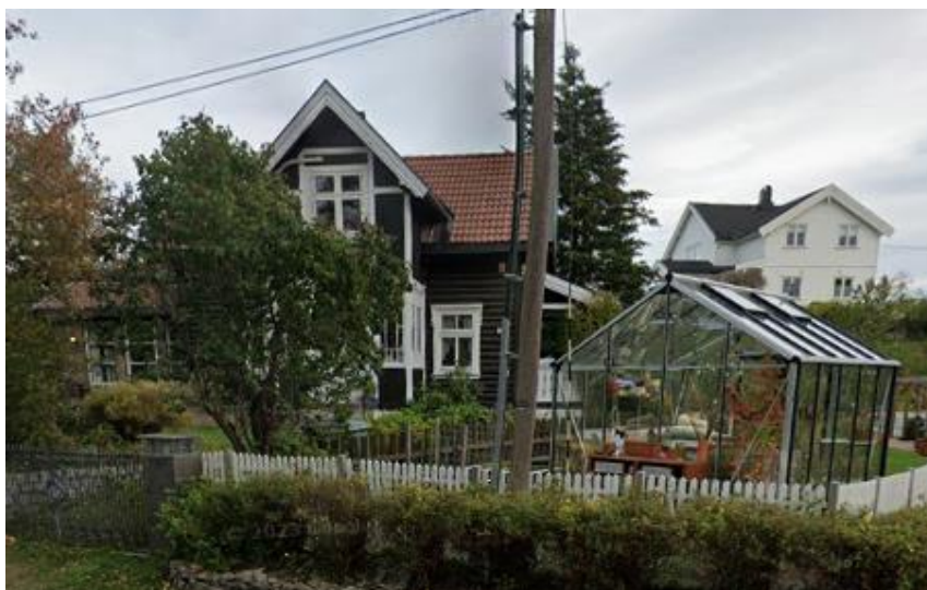
Bebyggelse i ny hensynssone kulturmiljø langs Sørliveien. Foto hentet fra Google Street View.
