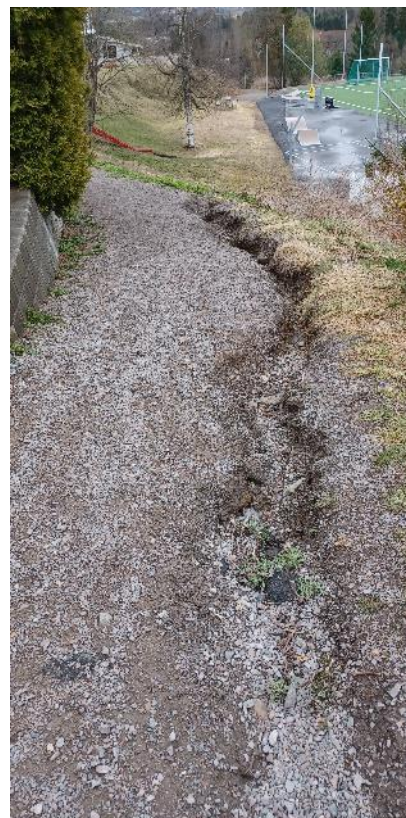
Erosjonsskader i gangvei i Kruttverket.
