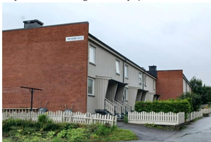
Rekkehusbebyggelsen i Nygård er vurdert med høy kulturmiljøverdi og er gitt hensynssone kulturmiljø.
