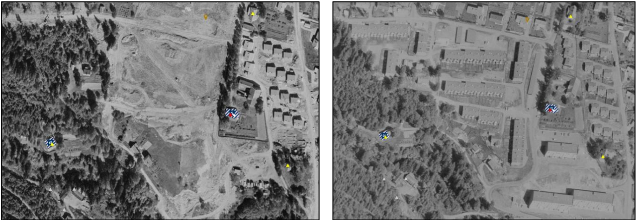
Figur 36: Flyfoto fra 1969 (t.v.) viser at grunnarbeidene ved Øvre og Nedre Nygård er godt i gang, men bygningene er ennå ikke bygd. På flyfotoet fra 1976 (t.h.) ser vi at både de tre boligblokkene og rekkehusanlegget er ferdig oppført. Kilde: Askeladden.no.
