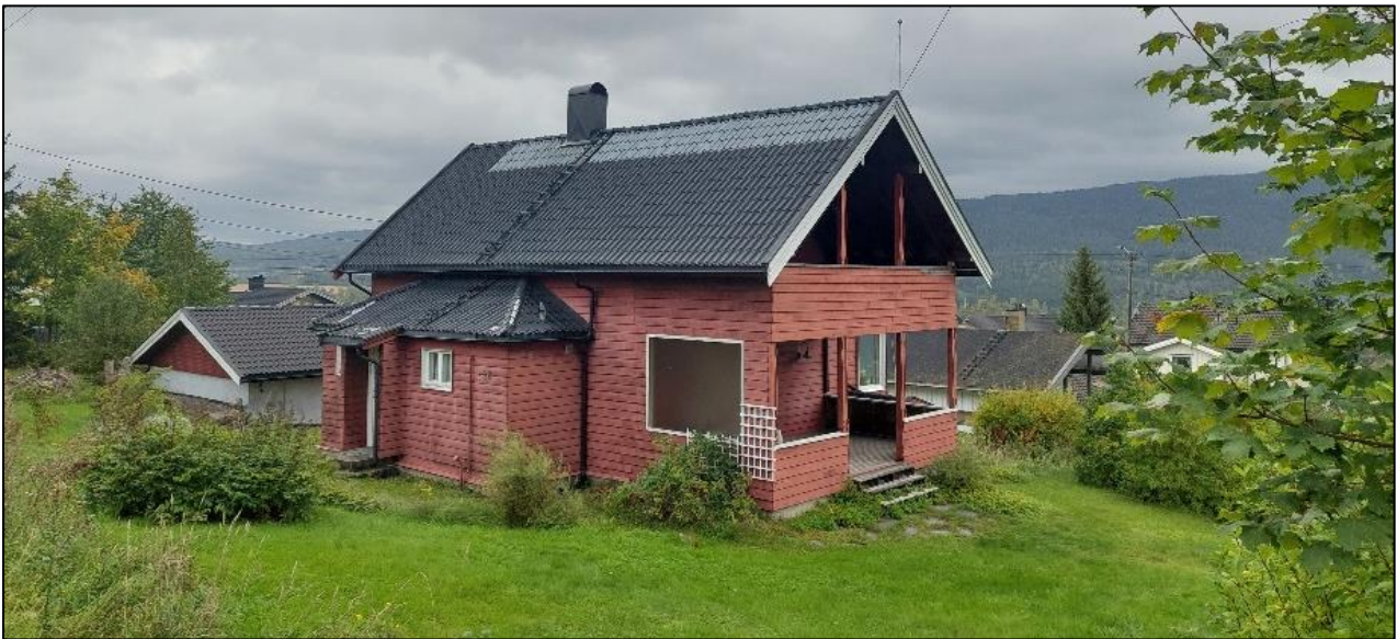
Figur 35: Stasjonsveien 28 er en bolig fra tidlig på 1900-tallet med sveitserdetaljer. Bygningen har høy lokalhistorisk verdi som tidligere lærerbolig for Rotnes skole (Miljøverndepartementet, 1983).
