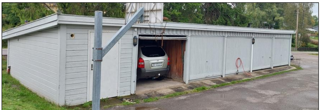
Figur 18: Et av garasjeanleggene på Bjertnes (Nr.5).
