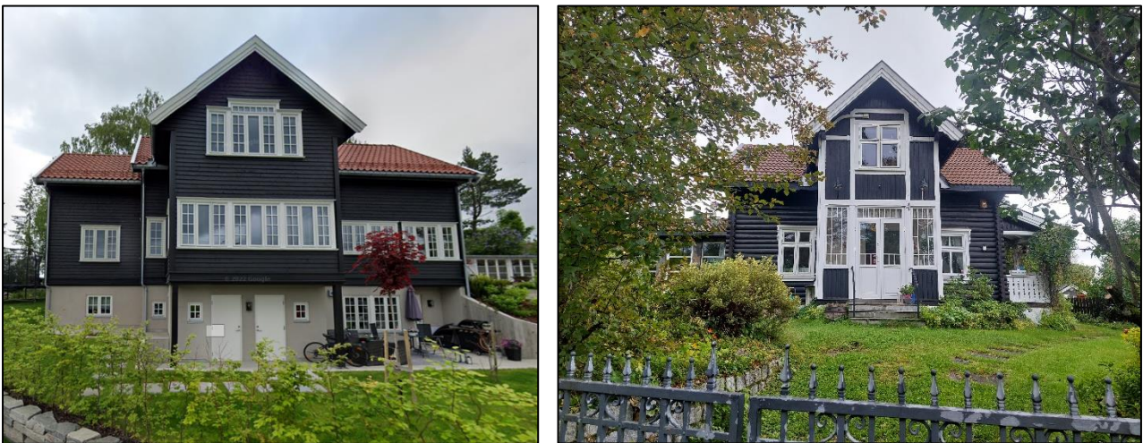
Figur 27: Eksempel på moderne tids sveitserstilshus, her ved Sørliveien 18 (t.v.), et ombygget SEFRAK-bygg. Til sammenligning ser vi til høyre Sørliveien 4 A, et opprinnelig sveitserstilshus med flotte sveitserdetaljer og laftet fasade.
