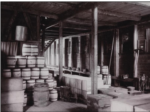
Figur 39: Nitedals Krudtværk, trolig på slutten av 1800-tallet. Lagringsrutinene var ikke like strenge den gang som i dag, Foto: L. Szacinski. Kilde: Nasjonalbiblioteket.no
