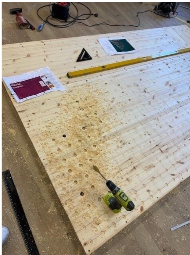
Figur 1. Bilde fra Miljøhuset Gnisten som laget veggene.
