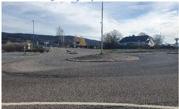
Foto viser rundkjøring ved Nittedalsveien.
